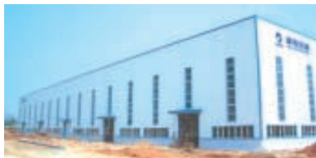
中国・風力発電機組立工場
